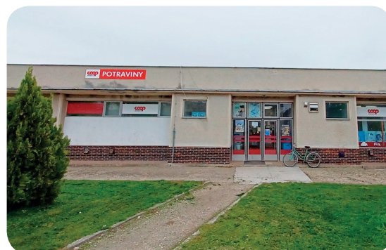
Budova PJ Lenartovce
